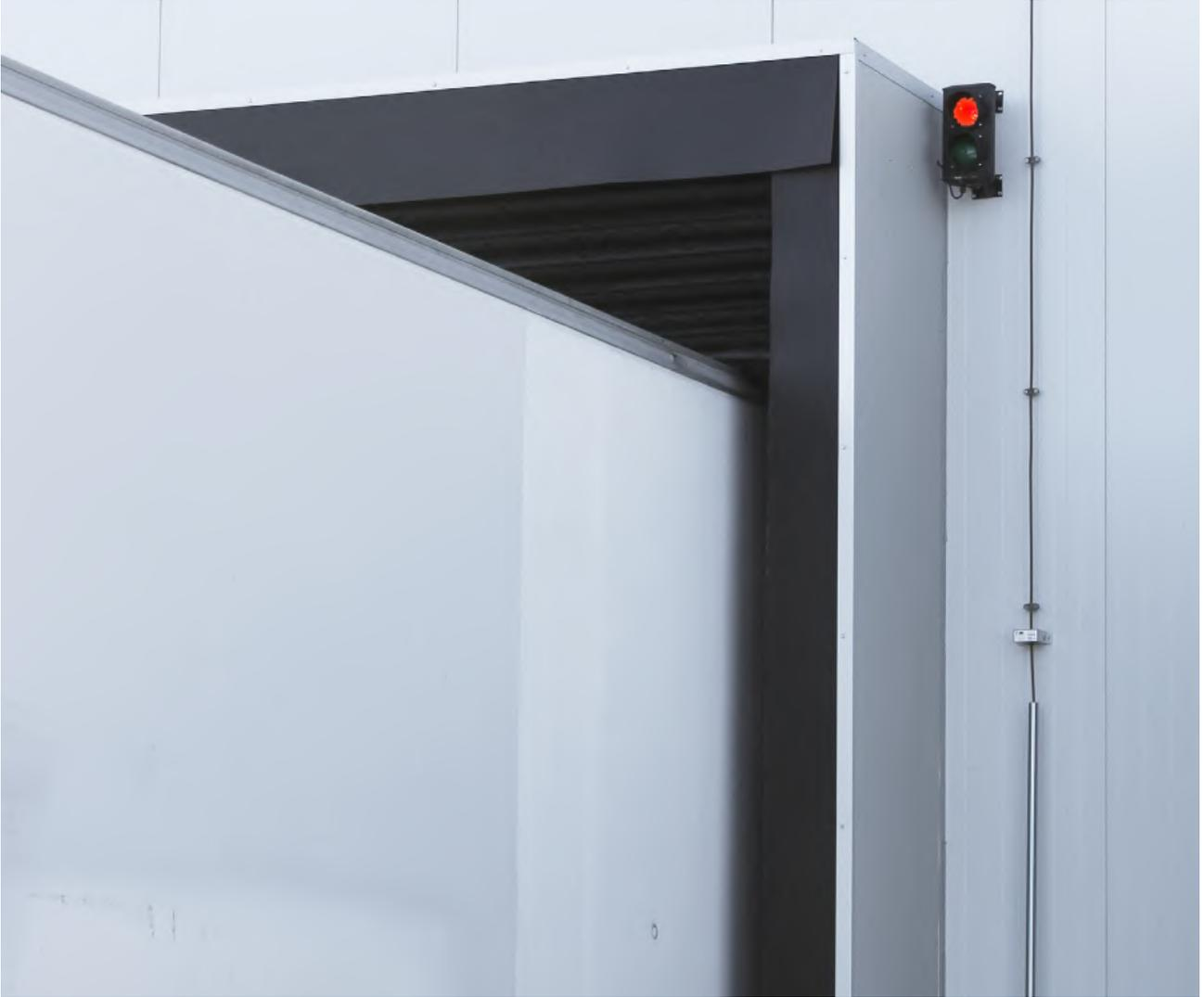
**El semáforo** es ideal en las instalaciones de muelles de carga. Mediante **luces led de color verde y rojo** indica al conductor la posibilidad de maniobrar durante la carga y descarga de mercancía.
